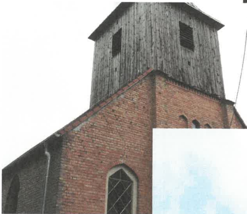
Kościół w Gościmcu. Drewniana XVIII wieczna wieża, wzniesiona nad południowo zachodnią częścią nawy kościoła. Opiertwie blacharskie jest współczesne, widoczne wygięcia i uszkodzenia blach oraz szpecące obiekty instalacje anten teleinformatycznych.
