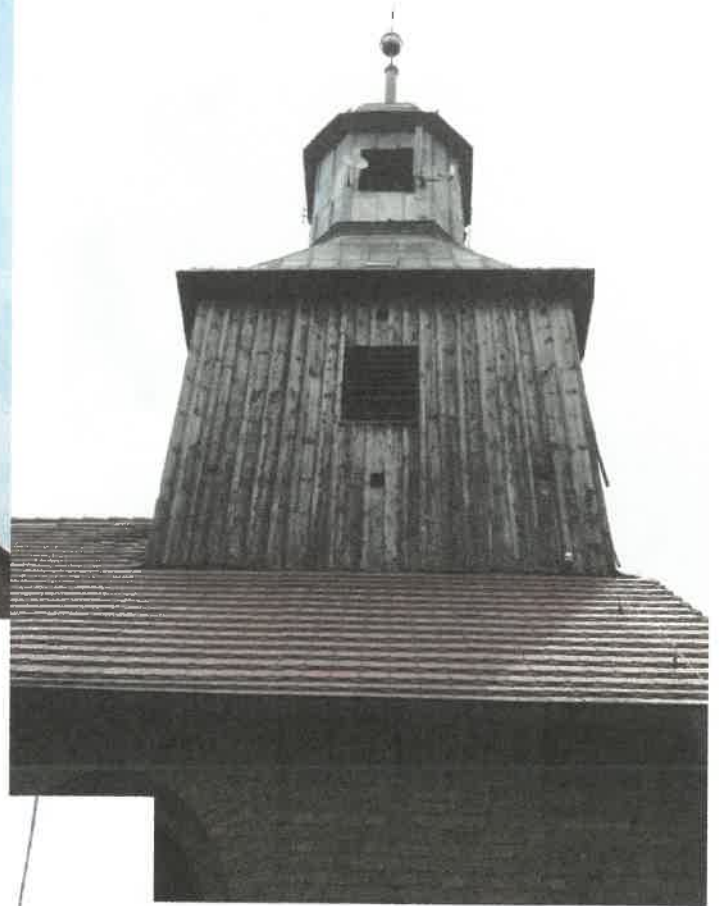
Kościół w Gościmcu. Drewniana XVIII wieczna wieża, wzniesiona nad południowo zachodnią częścią nawy kościoła. Opiertwie blacharskie jest współczesne, widoczne wygięcia i uszkodzenia blach oraz szpecące obiekty instalacje anten teleinformatycznych.
