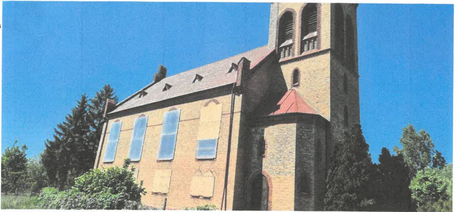
Kościół w Żółwinie obecny stan zachowania. Dachy nad przybudówkami pokryte współcześnie malowaną na czerwono blachą ocynkowaną.
