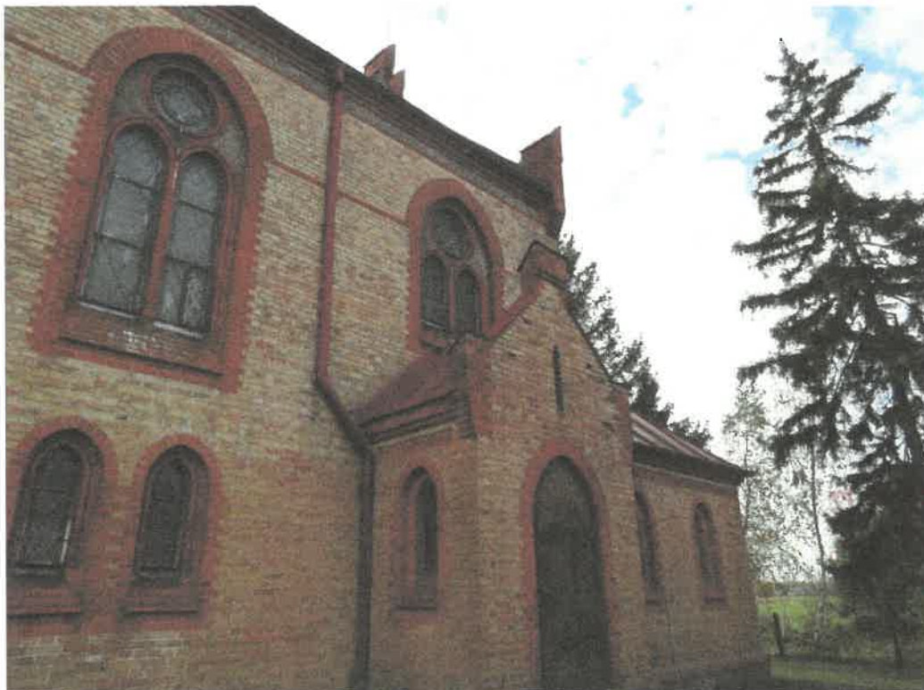
Kościół w Żółwinie obecny stan zachowania. Dachy nad przybudówkami pokryte współcześnie malowaną na czerwono blachą ocynkowaną.
